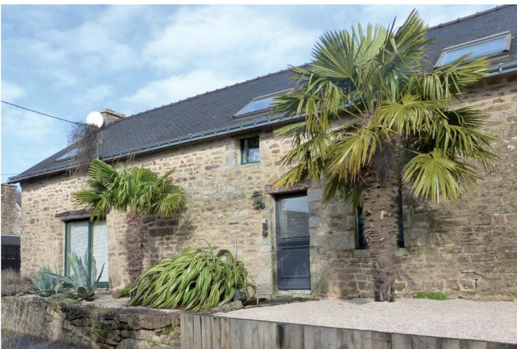
Rénovation bien exécutée qui a su conserver les ouvertures existantes et la volumétrie du bâti ancien. Le mortier de jointoiement a été réalisé à la chaux aérienne avec du sable pour trouver la teinte qui correspond le mieux à la pierre existante (le granit). Le résultat est très naturel et respectueux du matériau.
