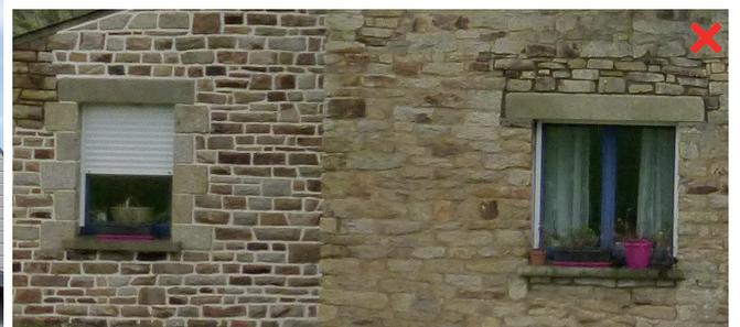
Exemple de joints réalisés sur un appentis en pierre (à gauche), qui viennent en rupture avec la maçonnerie du bâtiment principal (à droite). Il faut reprendre les techniques, matériaux et coloris pour assurer une bonne intégration avec l'existant, en évitant un effet patchwork.
