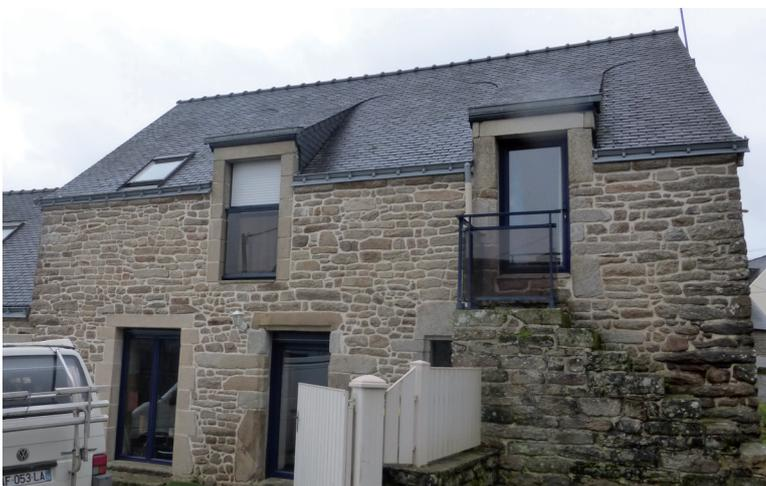
Exemple d'une rénovation dans le respect de la volumétrie avec réhausse en pierre des lucarnes rampantes existantes. Fenêtres de toit encastrées, coffres de roulant dissimulés, mortier de texture et couleur appropriée et menuiseries et garde-corps dans le respect des teintes du bâti existant et environnant. Gouttières nantaises et descentes masquées et peintes en fonction de la façade.
