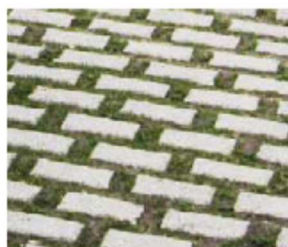
Pavage en béton avec ouvertures de drainage
